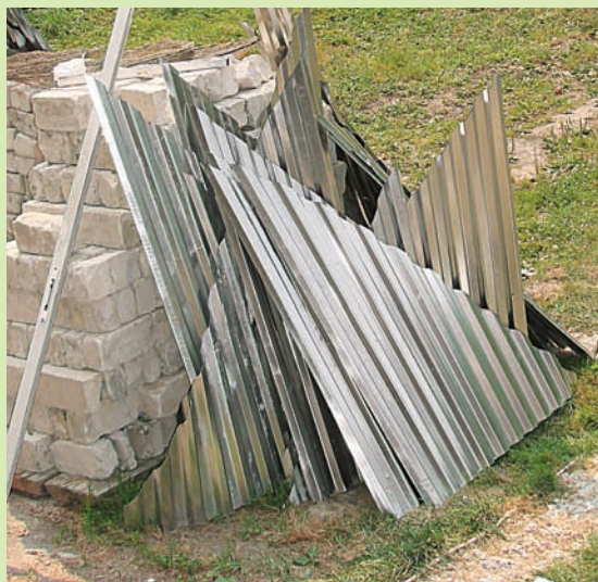
Так называемые отходы, часть которых пошла на углы крыши
